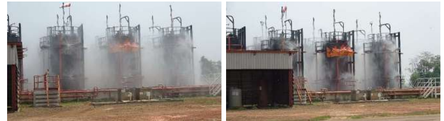
ภาพ 6 แสดงการเปิดใช้งานระบบหล่อเย็นถังน้ำมันดิบ (เปิด-ปิด ผ่านแผงควบคุมหน้าห้องควบคุม)
